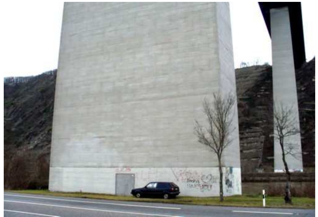
16 m breite und 7,50 m dicke Pfeiler werden das Moseltal nicht verschönern!
